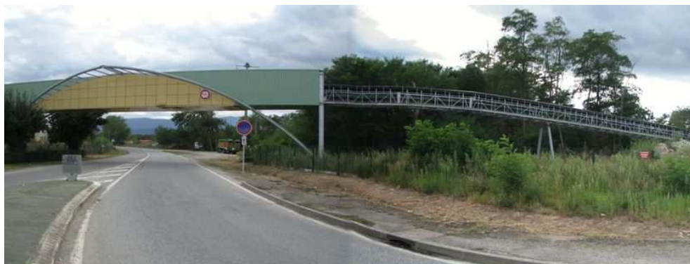
Passage des bandes transporteuses au-dessus de la RD 12
